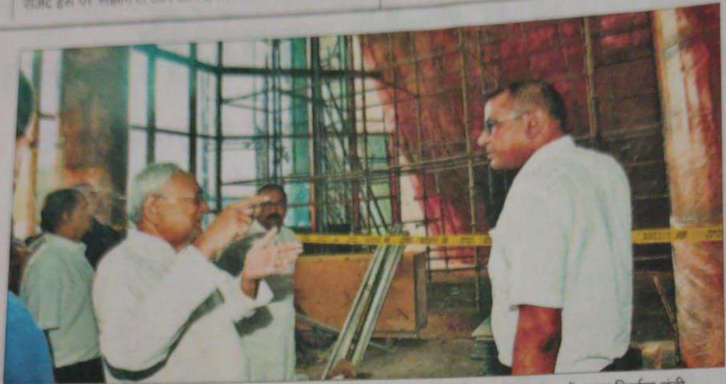
बुधवार को पटना के गर्दनीबाग में बन रहे बापू टावर का निरीक्षण करते मुख्यमंत्री नीतीश कुमार। साथ में भवन निर्माण मंत्री अशोक चौधरी व सचिव कुमार रवि।
